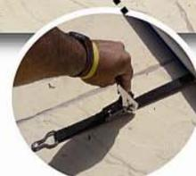
A Cobertura de Segurança é estabilizada através dos fixadores existentes a cada topo da cobertura e nas laterais (o seu nº depende da largura da piscina) que incluem uma fita de 25mm de polietileno, 1 esticador e 1 piton escamoteável de aço inox para pedra, ou estaca aço inox tipo cantoneira, no caso de relva.
