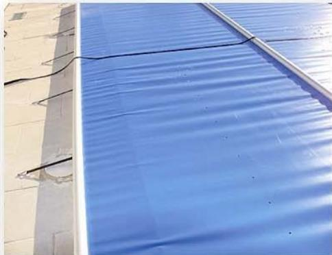
O escoamento das águas é garantido através da aplicação de orifícios ao longo do comprimento da cobertura.
